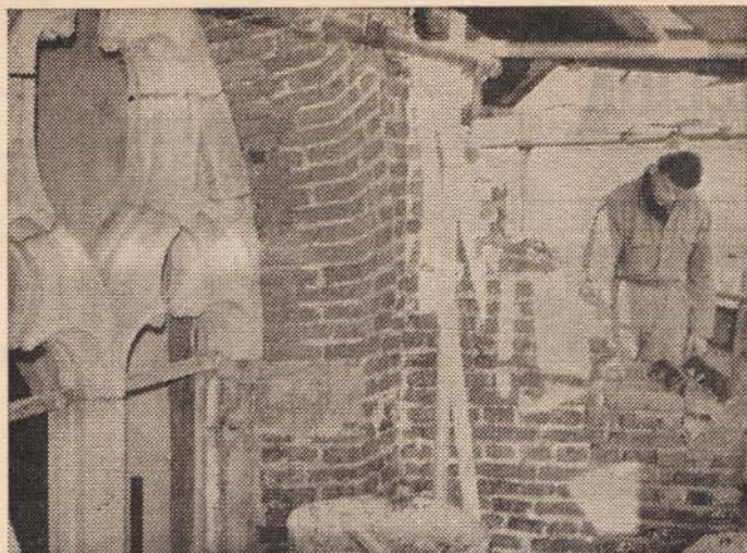
Restauratie hervormde kerk te Delden. Duidelijk zijn de nieuwe raamstijlen van de oude te onderscheiden. De metselaar is bezig met het herstellen van een van de steunberen der kerk.
